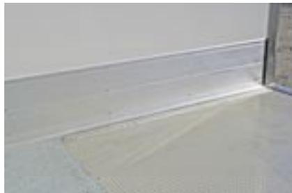
Kunststoffboden mit Aluminium-Gerstenkornblech und Aluminium-Scheuerleiste.
